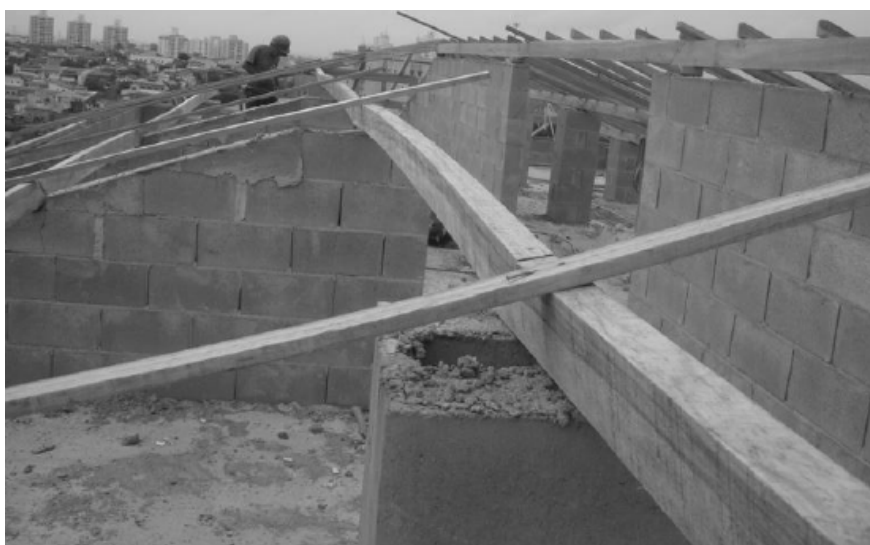
Figura 10 – Detalhe do desalinhamento das terças.
