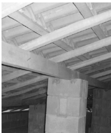
Figura 6 – Apoio de uma das terças em um dos pilares.
