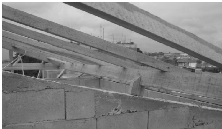
Figura 9 – Detalhe do pontalete fixado com instabilidade.
